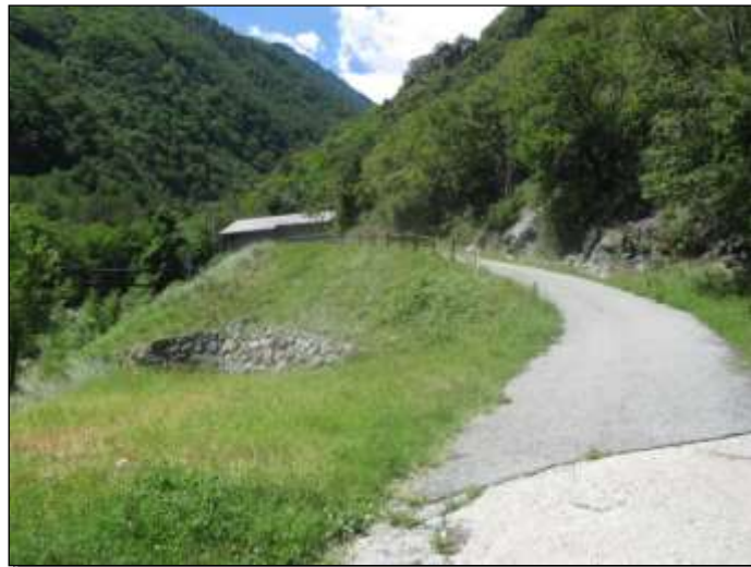
Foto 4.3-8: Vista da valle del settore apicale del conoide del T. Boccoil ove verrà realizzato il nuovo serbatoio di Sommet de Ville
